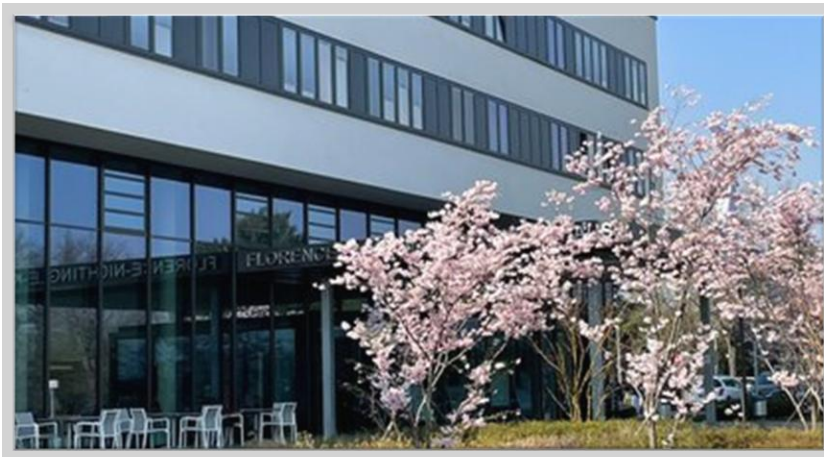
Das Florence Nightingale Krankenhaus
